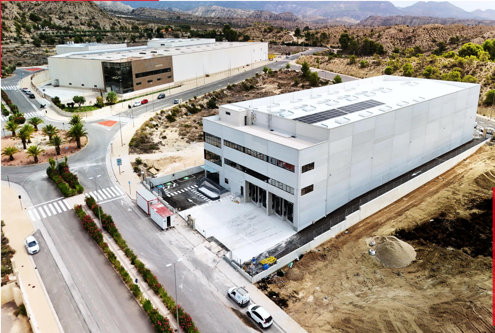
JOMIPSA, Construcción de una nave industrial en Mutxamel
