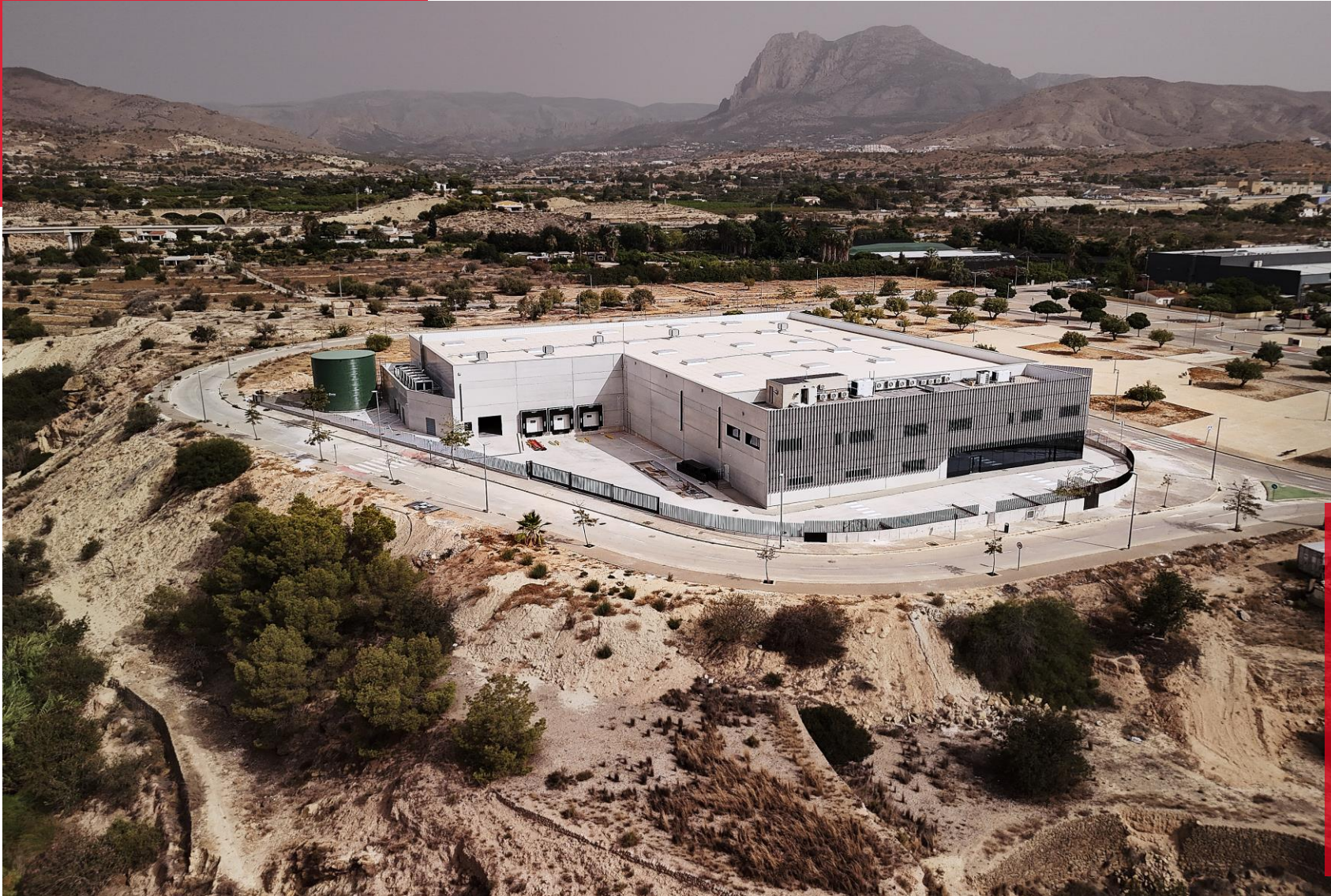
CHOCOLATES CLAVILEÑO, Construcción de una nave industrial en la Vila Joiosa
