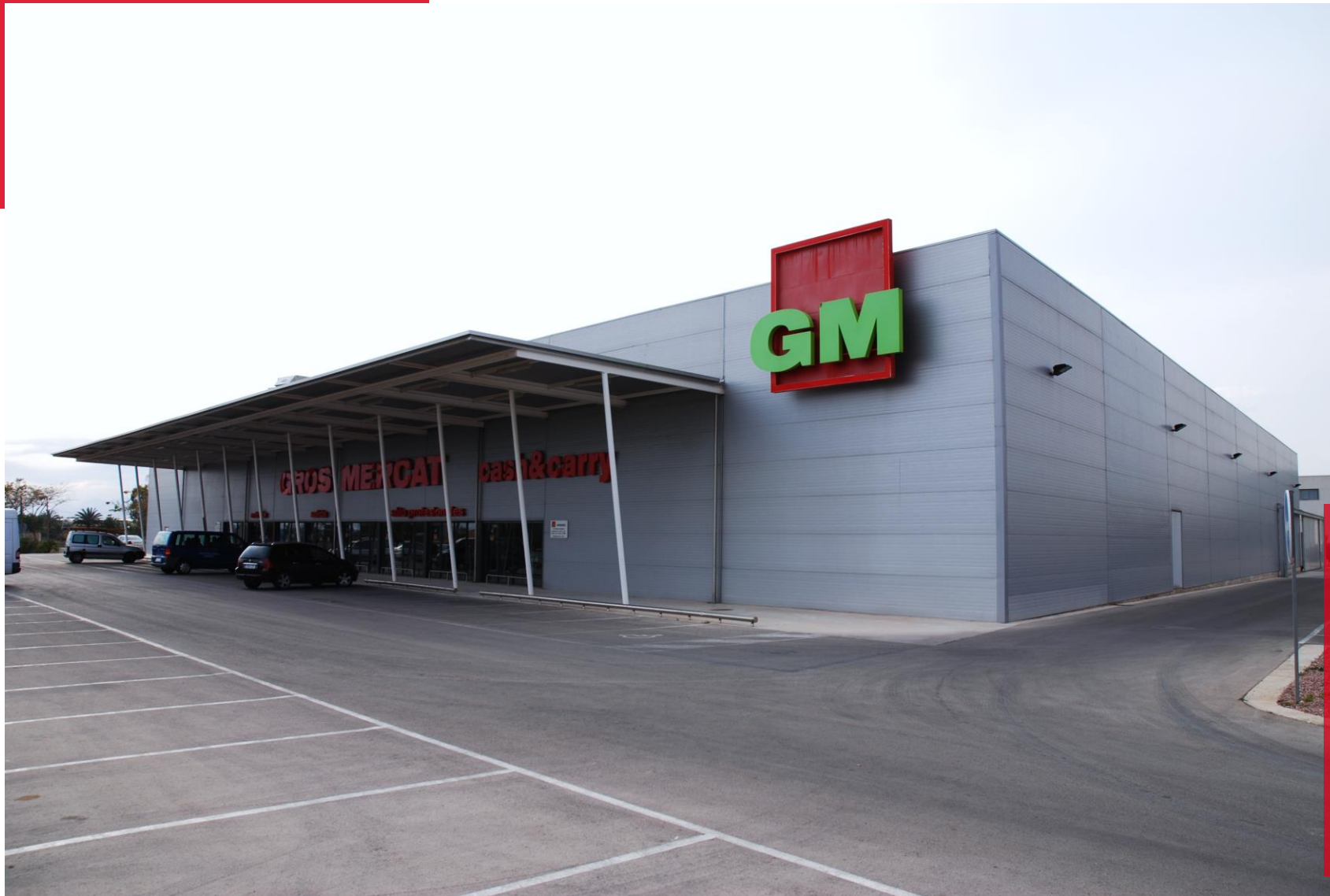
GROSS MERCAT, Construcción de una nave industrial destinada a supermercado en el Polígono Industrial de Elche
